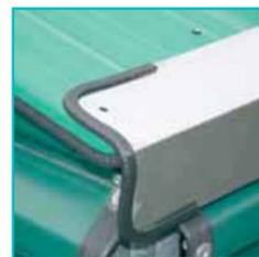
Protection des extrémités des tôles par un nez caoutchouc. Protection des angles de toiture par des faitages en tôle galvanisée pliée.
